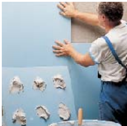
Polystyreenivaahkotelevyjen asennus LAATTA-FLEXillä
