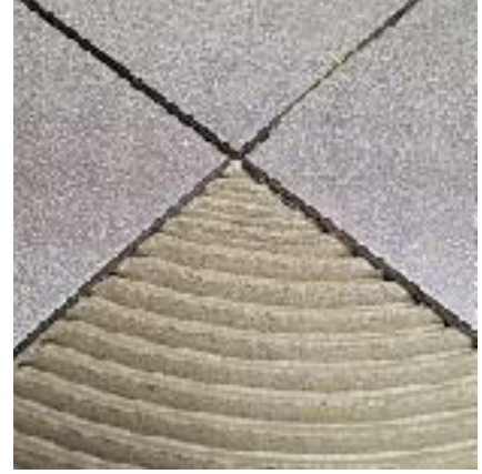
Kuivapuristelaattojen laatoitus LAATTA-FLEXillä
