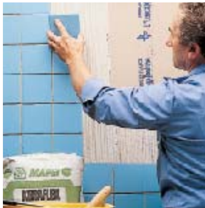
Kipsilevyjen laatoitus LAATTA-FLEXillä
