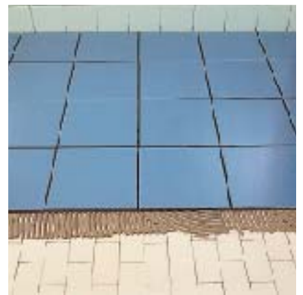
Vanhon laatoituksen päälle laatoitus LAATTA-FLEXillä
